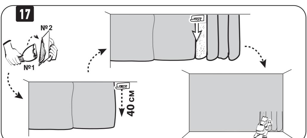
Повторяйте действия 4-16, пока не нанесете материал на всю поверхность. При работе с материалом у пола, наносите материал снизу (от поверхности пола) вверх (к ранее нанесенным участкам).
